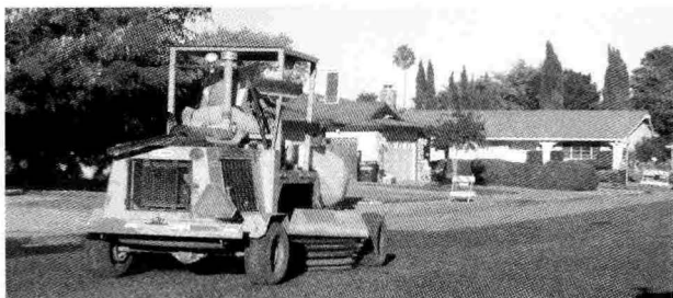
图 21 滚刷在进行中间复拌工序
