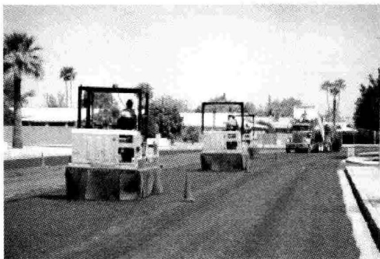
图 24 用帆布围起的轮胎压路机
